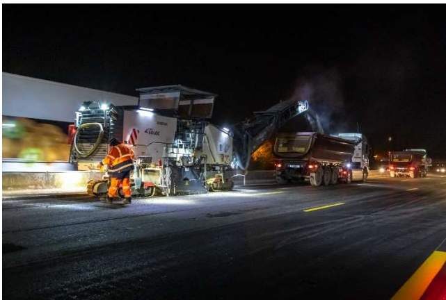
Rabotage de l'ancienne chaussée
